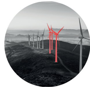
INSTALLAZIONI SOLARI ED EOLICHE SOLAR AND WIND INSTALLATIONS
